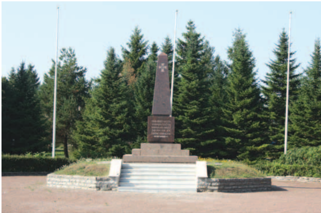
1939. aastal püstitatud Jõelähtme vabadussammas sai Jõelähtme vallavalitsuse rahastamisel uue trepi. Tööd teostas AS Põhjakivi ja ehituse kogumaksumuseks kujunes 2852 eurot. Korrastatud sai ka ausamba esist platsi.
